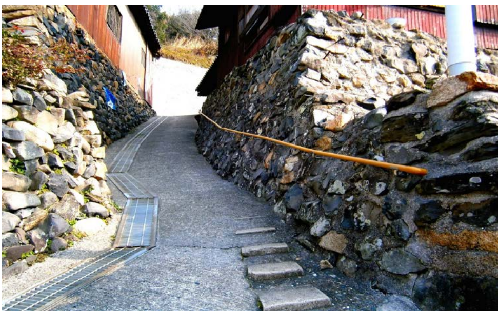
中腹部主要生活道(工事完成日:2017年1月19日)
