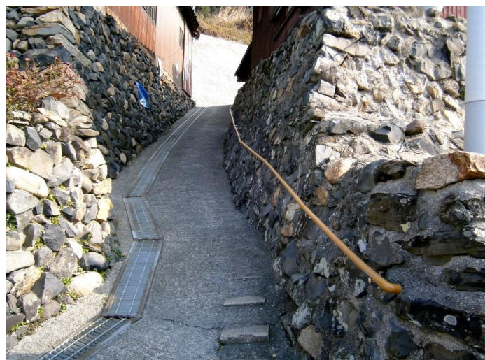
手摺-1 取付施工完了
