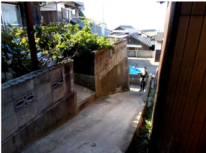
急勾配通路②の現状
