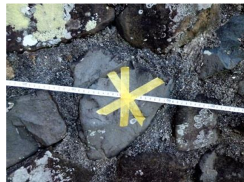
手摺受アンカー の墨出
