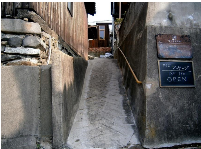
手摺-2取付施工完了
