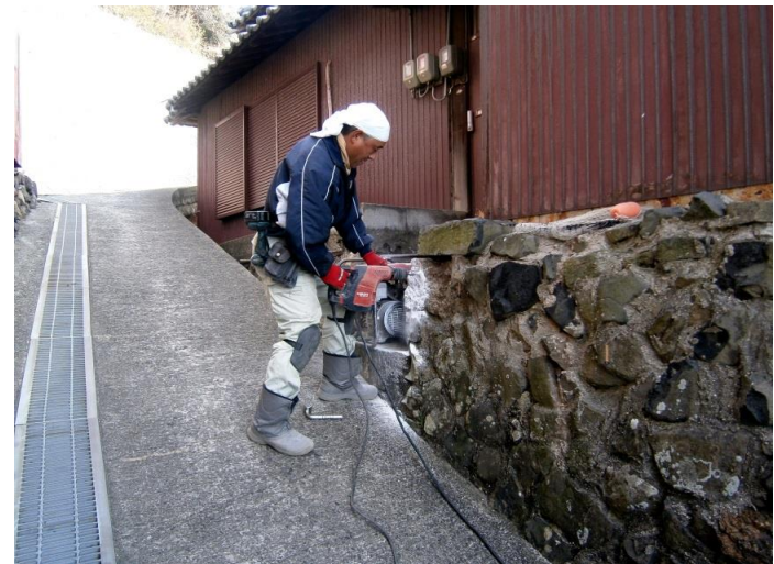
手摺受座のアンカー穴明け
